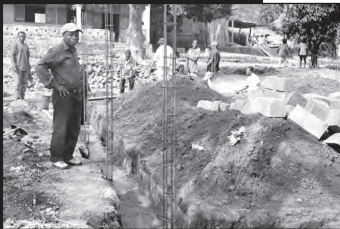
Alphose Tay sur un de ses chantiers
