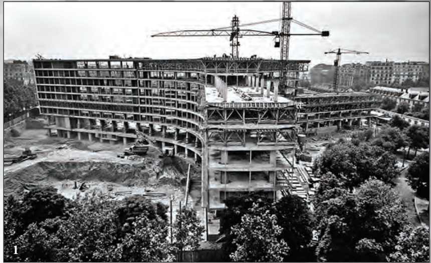
Un bâtiment en étoile à trois branches.
