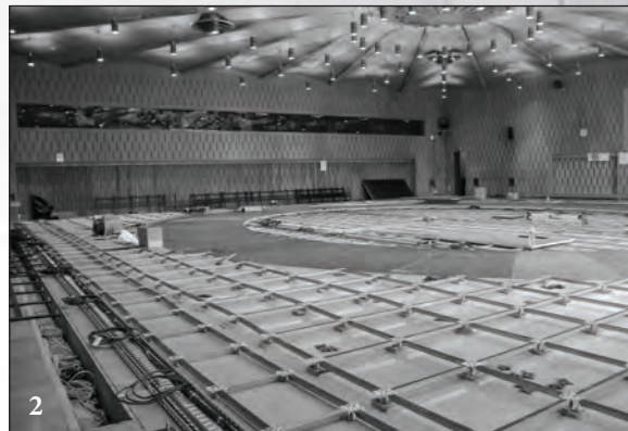
Rénovation de la salle X du Conseil exécutif : pose du sol technique (août 2015).
