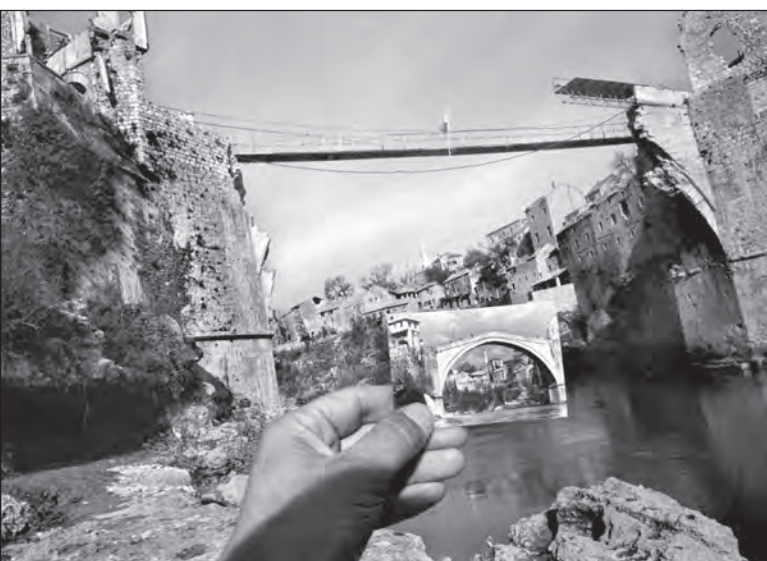
Pont de Mostar, détruit en 1993 et reconstruit en 2001. Photo : © DR
